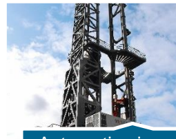
Automatisering av boring
